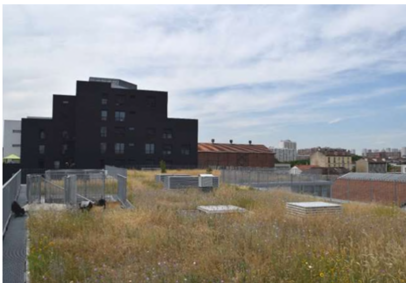
Figure 145 : Exemple de toiture semi-intensive -Ecole Rosalind Franklin, Ivry-sur-Seine (Hemminki Johan, 2018)
