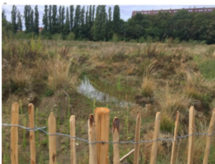
Figure 144 : Exemple d'implantation de clôture "châtaigniers »
