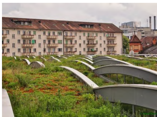
Figure 148 : Toit végétalisé du dépôt de Tram de la ville de Bâle - Un projet innovant : une construction légère avec une couche drainante en paille de miscanthus de 10cm ( http://naturentoit.blogspot.com/2014/07/le-wiesenteppich-de-bale.html )
